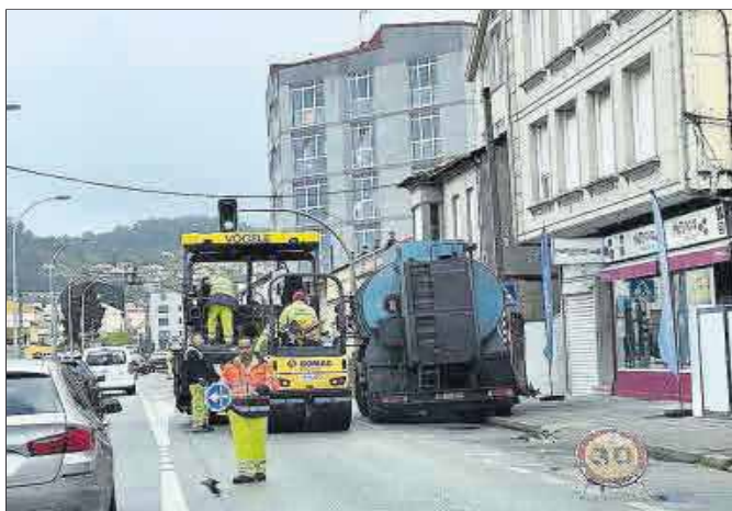
Operarios asfaltando y regulando el tráfico en Rodeira. // G. Núñez
