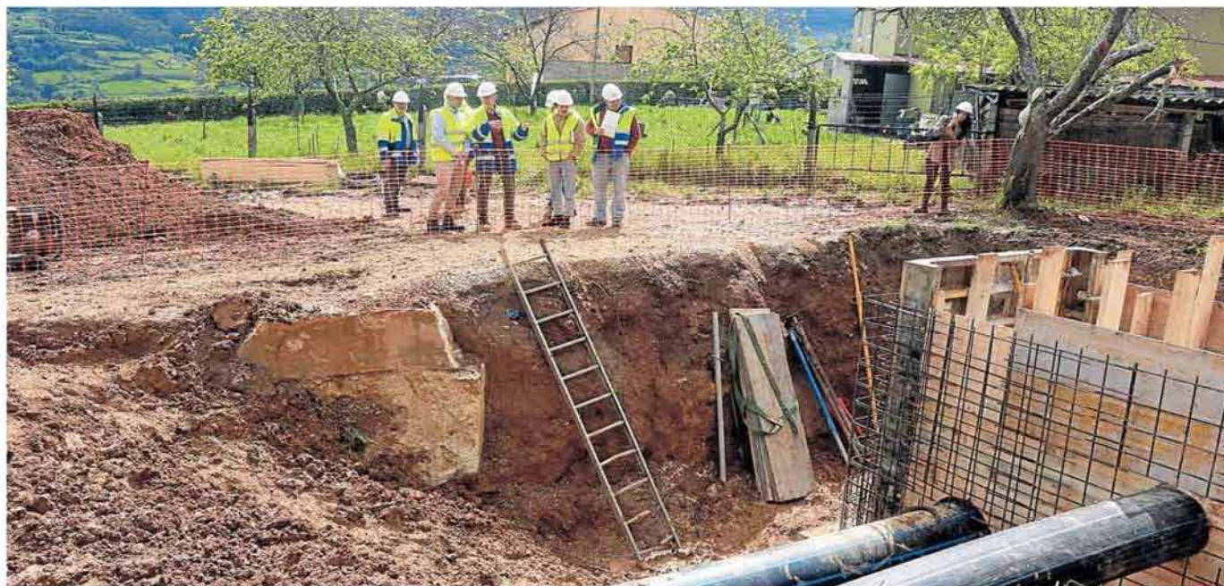
Uno de los tramos de la traída de Los Arrudos en trabajos de remozado se sitúa en la parroquia de Fano, adonde ayer acudió el concejal Martínez Salvador. FOTOS: JESÚS MANUEL PARDO
