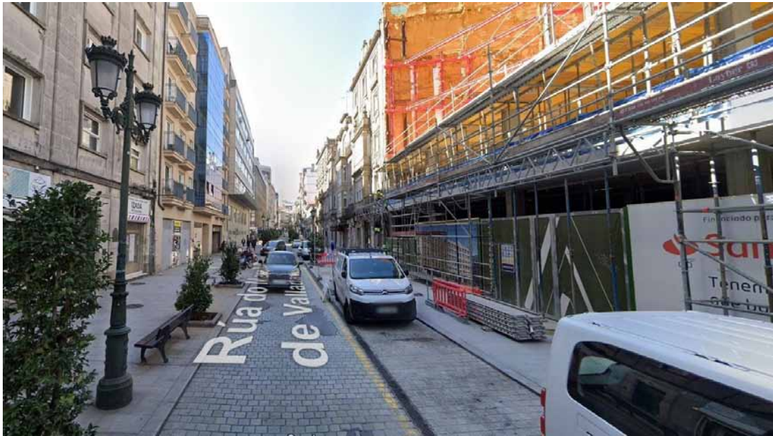
photo_camera La calle Marqués de Valladares se verá afectada por unas obras. // Google Maps
